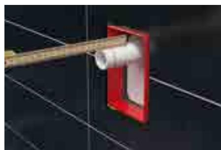
6.Obeležiti dužinu od 3 cm na navoju, merni od zida odnosno pločice.
